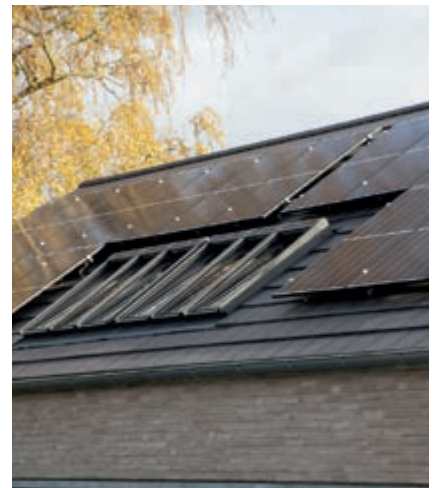
Aufdach-PV: Installation der PV-Module auf der Dacheindeckung.
